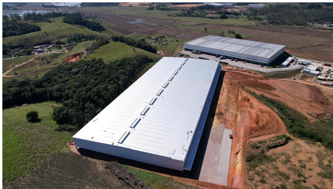
Construção Nave 2 – Foto Panorâmica
