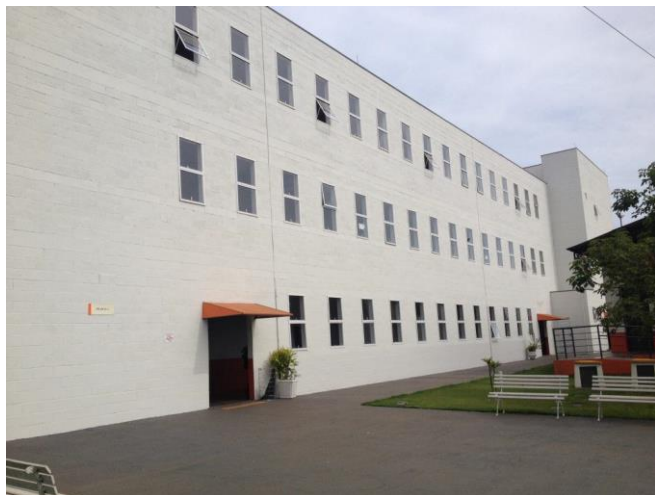
Bloco C – Fachada
