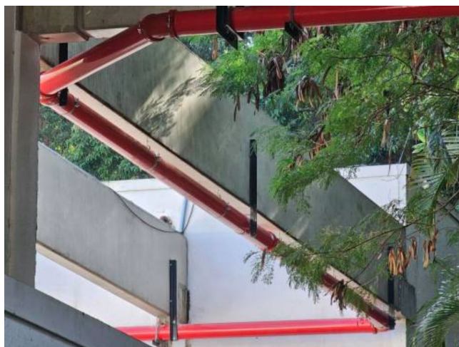
Instalação da tubulação de incêndio.
