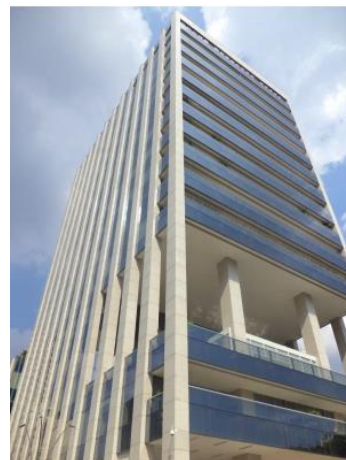
Fachada Traseira do Imóvel
