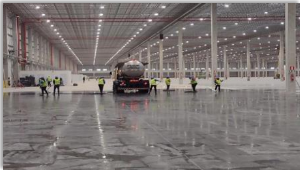
Limpeza Interna do Galpão
