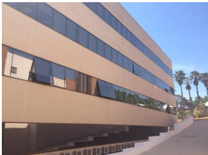
Bloco Administrativo 02 – fachada lateral
