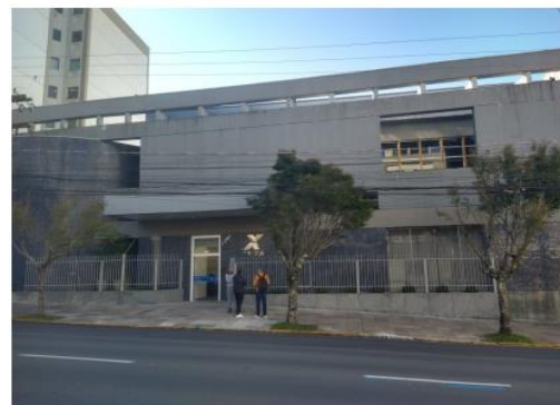
Fachada da edificação
