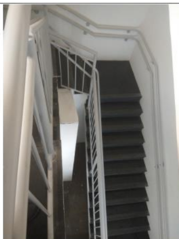
Corrimãos e guarda-corpos instalados na escada da agência
