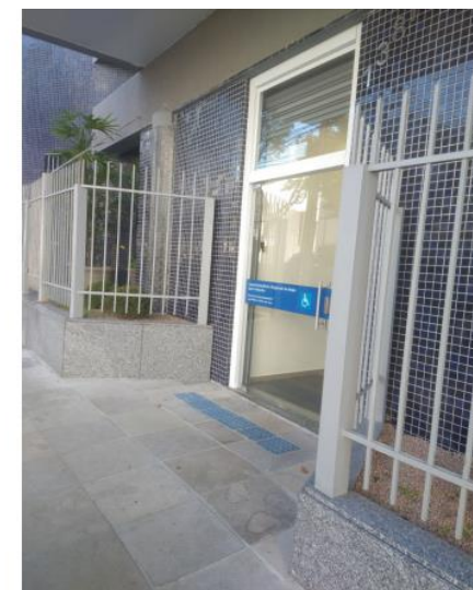
Porta de acesso (segregação acesso da agência)
