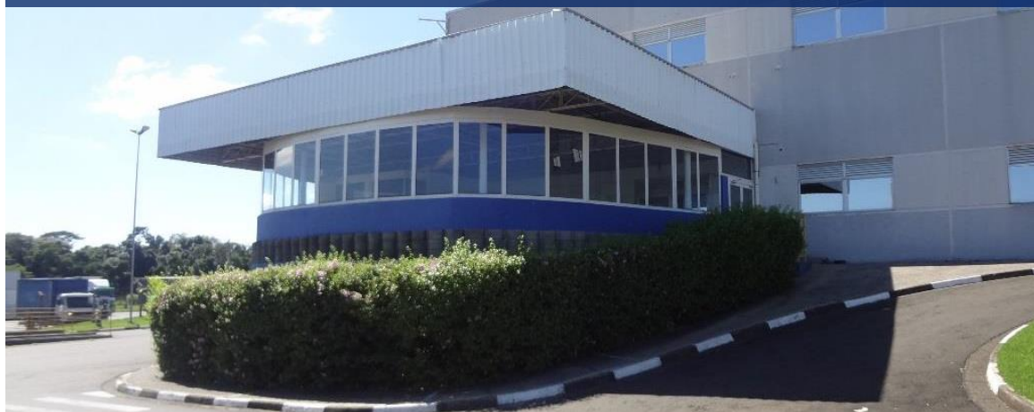
Entrada do galpão
