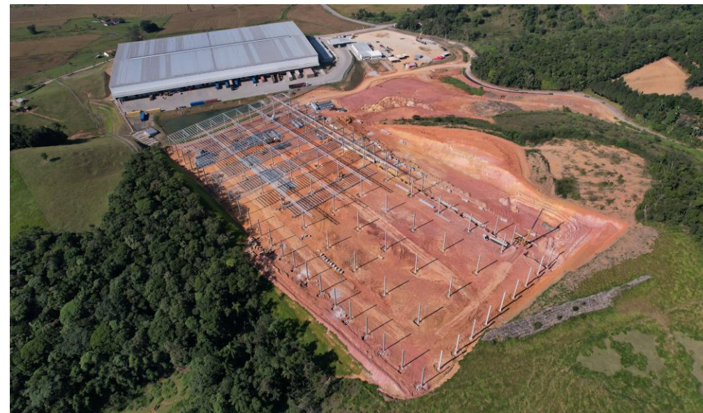
Construção Nave 2 – Foto Panorâmica
