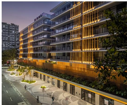
Fachada Essencia – Leblon Lançamento: 2022 | 100% vendido
