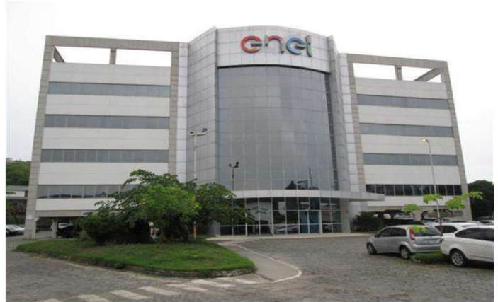
Ampla - São Gonçalo, RJ
