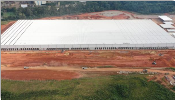
Término Fechamento Lateral do Galpão
