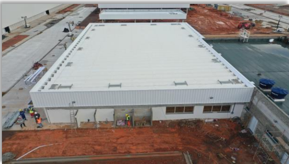
Prédio Refeitório (fase de acabamentos finais)
