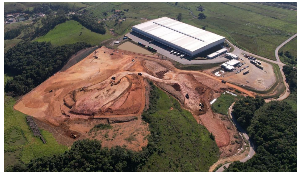
Terraplanagem Nave 2 – Foto Panorâmica
