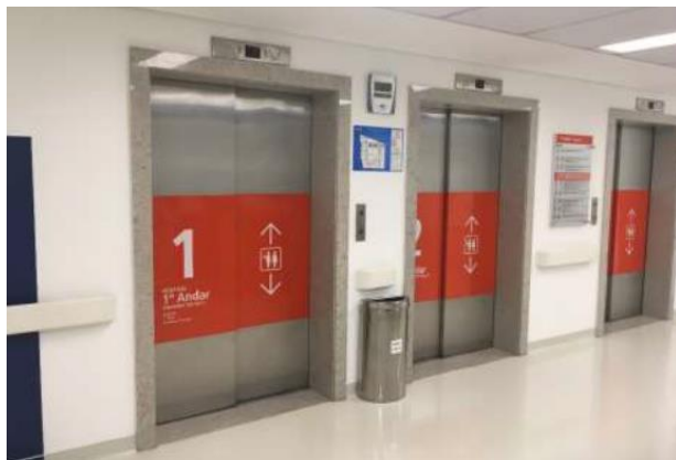
Hall dos Elevadores
