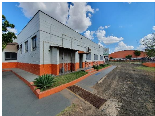
Vista Interna do Imóvel
