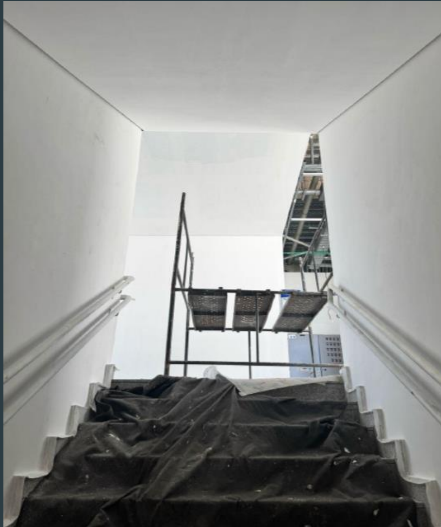
Visão Geral - Pintura Final
