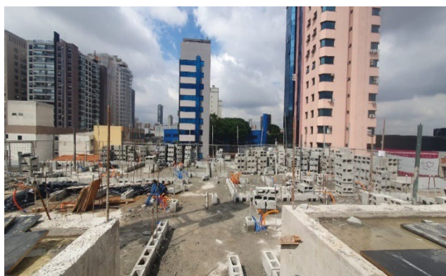
Marcação alvenaria estrutural – 4º Pavimento lado A.
