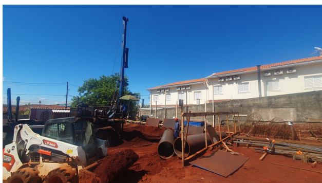
Execução de estacas escavadas e terraplenagem.
