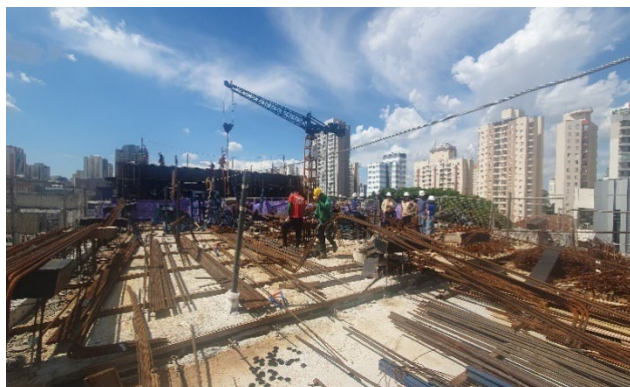
Laje 3º pavimento – Lado A.
