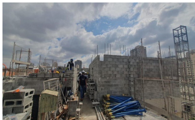
Alvenaria estrutural – 4º Pavimento lado A.
