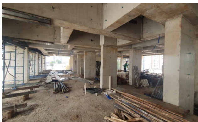
Estrutura – 3º Pavimento.
