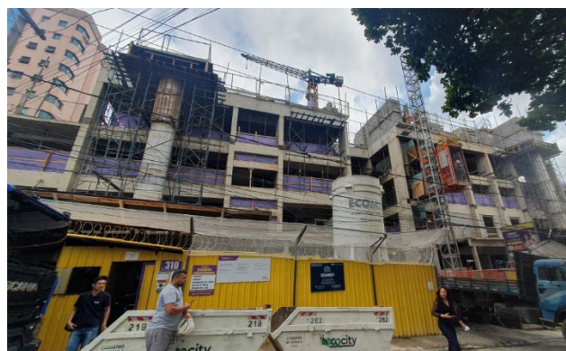
Visão fachada (mar/25).
