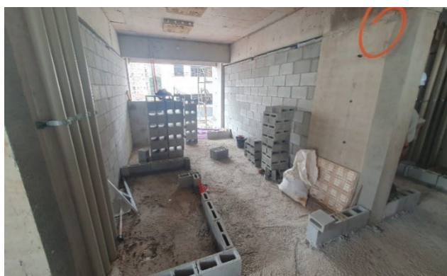
Alvenaria de vedação e instalações – unidades NR 1º Pavimento.
