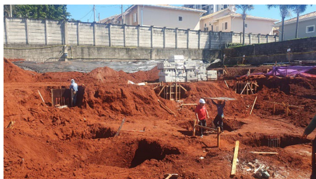
Execução de blocos de fundação.
