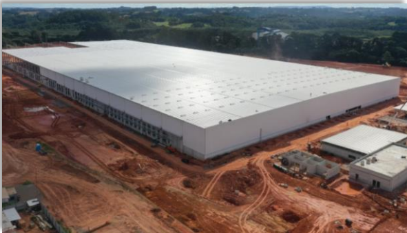
Vista Aérea da Obra
