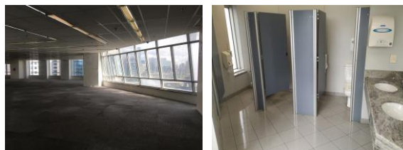
Fotos do espaço e banheiro do 8º andar
