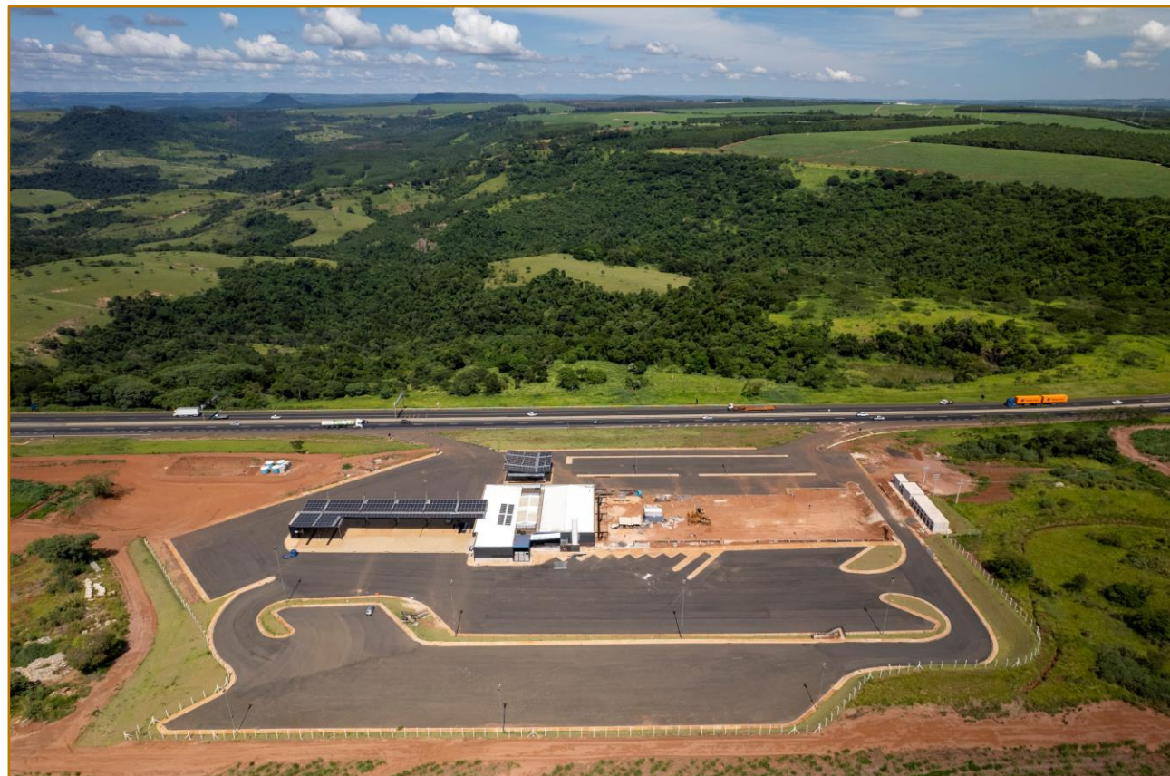
Posto de Combustível da Rede Monte Carlo, localizado na Rodovia Washington Luís, km 198, Corumbataí – SP.
