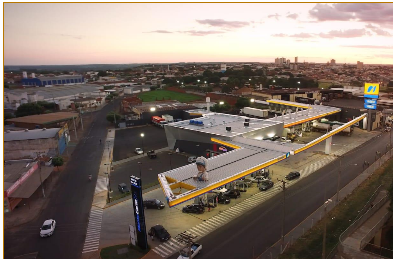
Posto de Combustível da Rede Monte Carlo, localizado na Avenida Santos Dumont, 4235, Loteamento Jardim Marilu, Mirassol – SP.
