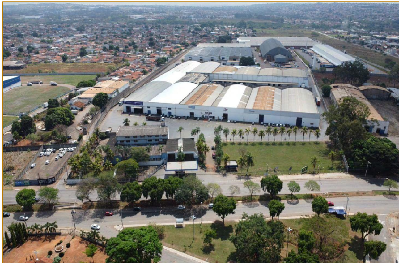
Complexo logístico da Goiazem Armazéns Gerais, localizado na Avenida Perimetral Norte, 10.002, Vila João Vaz, Goiânia-GO.
