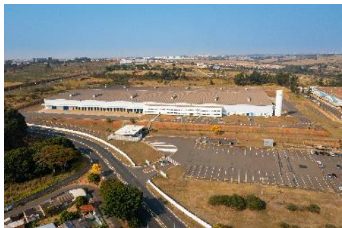
Galpão Hortolândia II
