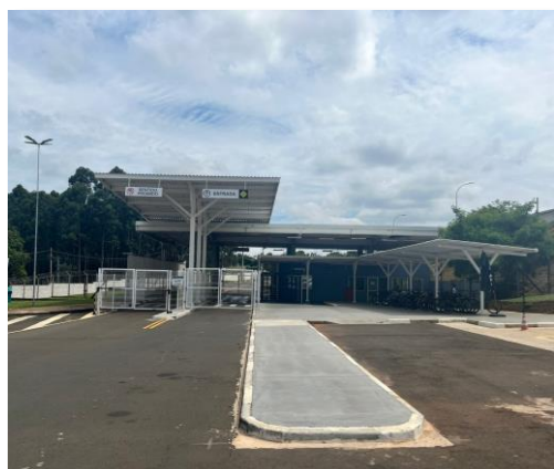
Retrofit do Galpão Hortolândia II
