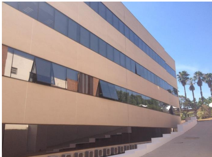
Bloco Administrativo 02 – fachada lateral
