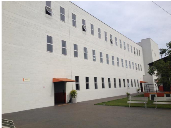
Bloco C – Fachada
