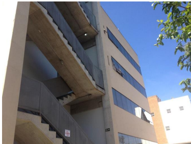
Fachada do Bloco Administrativo 02 – escada de emergência
