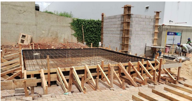
Fundação do reservatório e bases de pedestais da tubulação de incêndio
