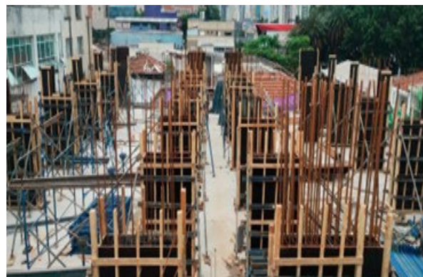
Armação e forma pilares do 2º pavimento lado B.
