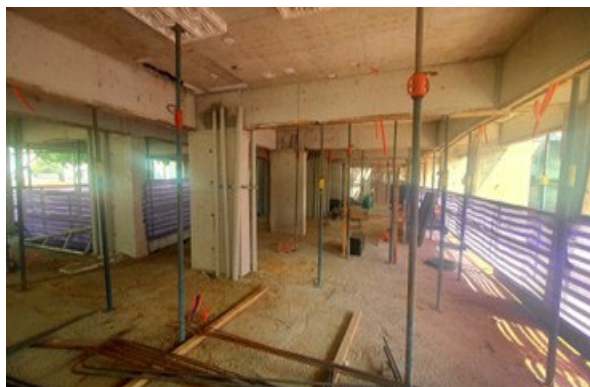
2º Pavimento – Reescoramento laje e prumadas e instalações hidrossanitárias.
