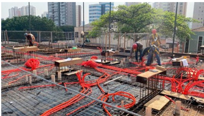
Armação laje do 2º pavimento lado A.
