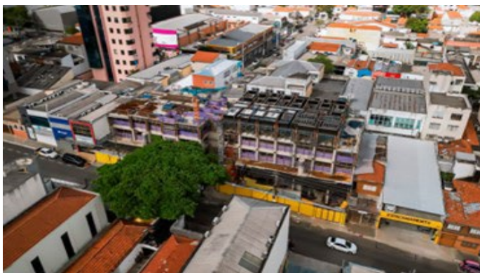
Imagem aérea – Estrutura 3º e 4º pavimentos.
