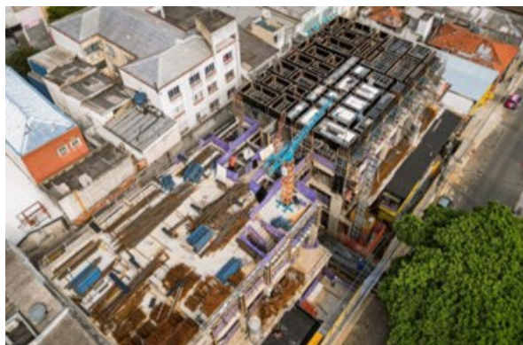
Imagem aérea – Estrutura 3º e 4º pavimentos.
