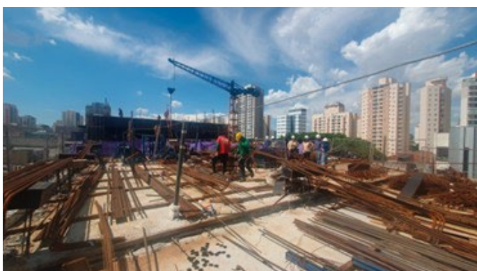
Laje 3º pavimento – Lado A.
