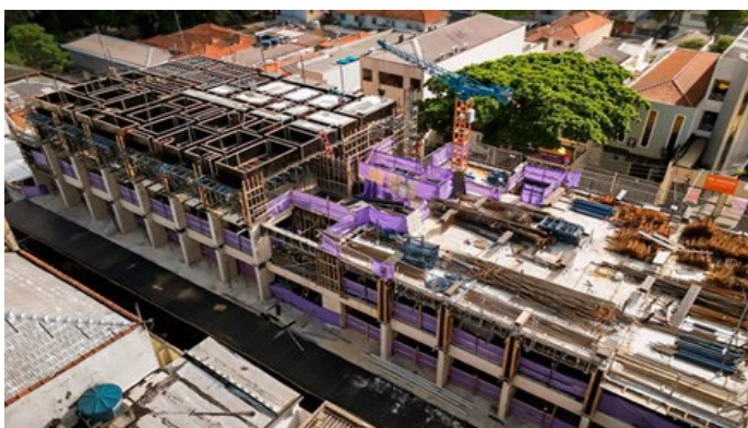
Imagem aérea – Estrutura 3º e 4º pavimentos.
