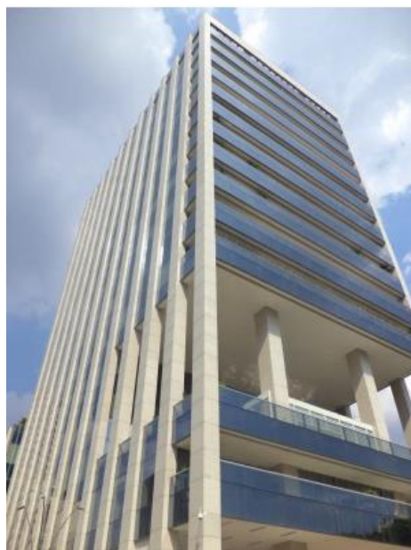
Fachada Traseira do Imóvel
