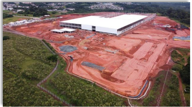
Vista Aérea da Obra
