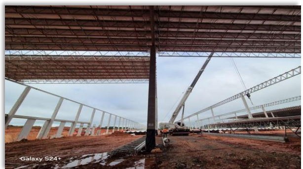
Montagem de Módulos da Cobertura
