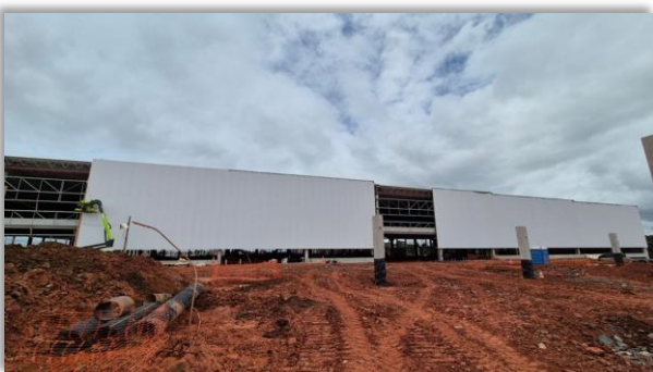
Fechamento frontal do Galpão
