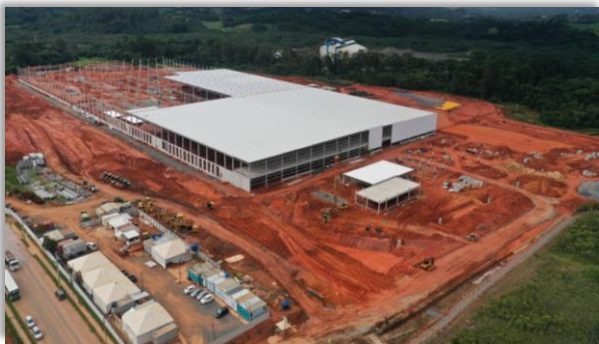
Vista Aérea da Obra
