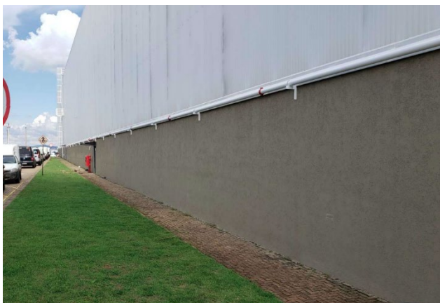
Nova tubulação principal do sistema de combate a incêndio.
