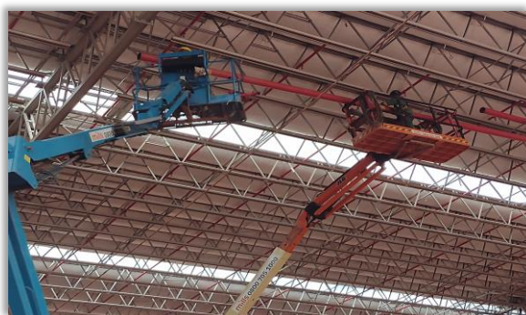
Montagem dos Bicos de Sprinklers
