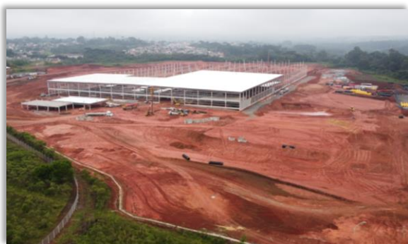
Vista Aérea da Obra
