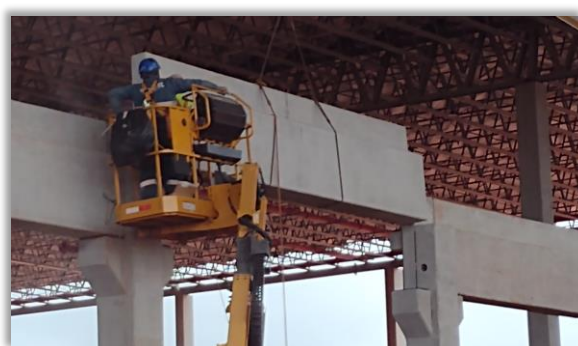
Montagem de Vigas Pré-Moldadas do Mezanino
