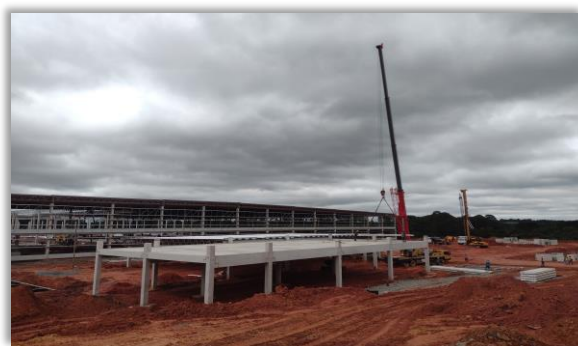
Montagem de Vigas e Lajes Pré-Moldadas do Refeitório
