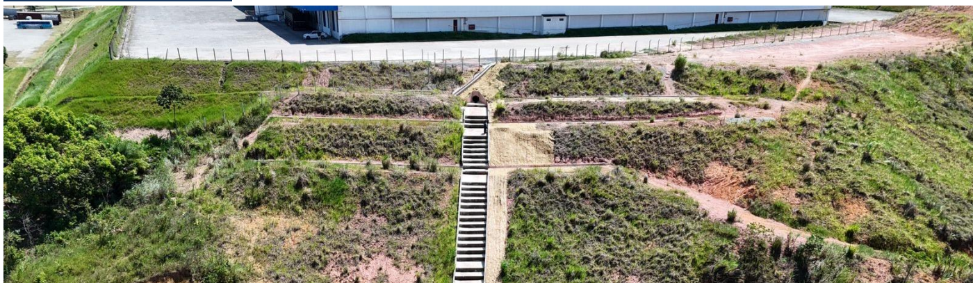
Imagem 6: Reparos no Talude
