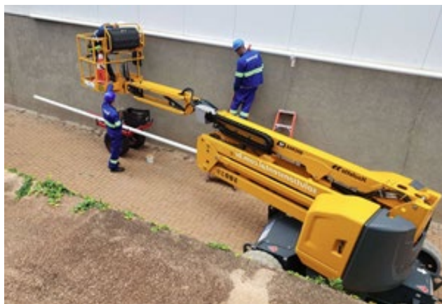
Fotos da instalação de tubulação de rede principal de incêndio.
