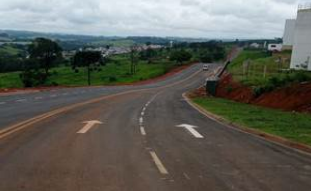
Fotos da nova avenida com sinalização recém executada.
