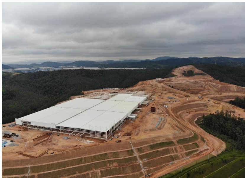
Execução de obras – Foto Panorâmica
