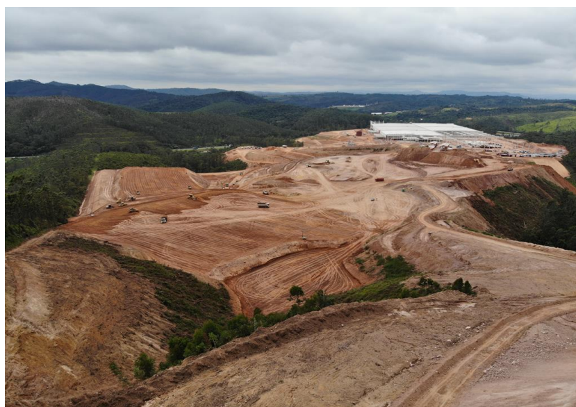
Execução de obras – Foto Panorâmica
