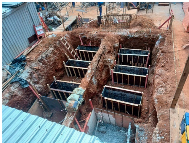
Bloco do edifício anexo.
