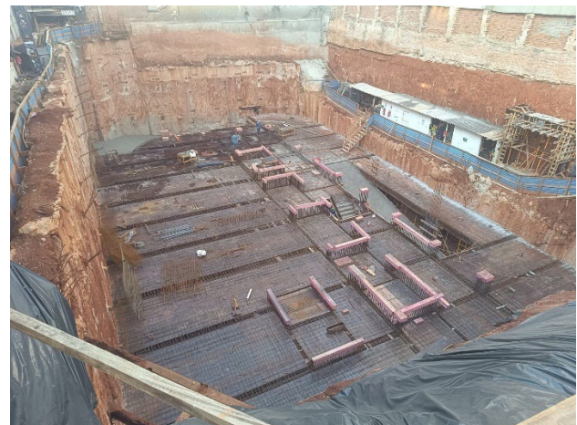
Armação da laje do 3º Subsolo.
