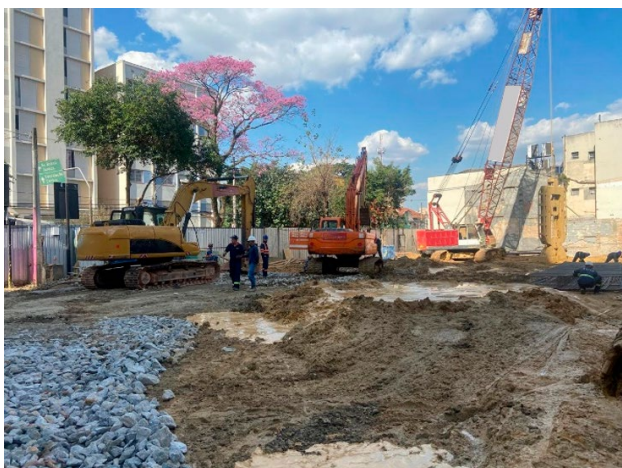
Execução de parede diafragma em agosto/24.
