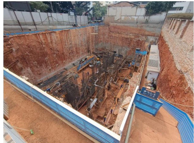
Armação pilares do 4º Subsolo.
