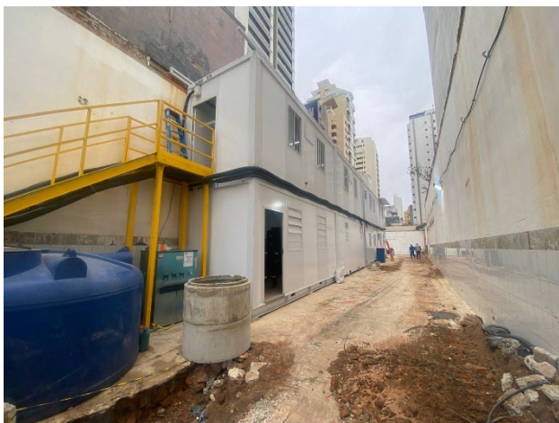
Canteiro de obras.
