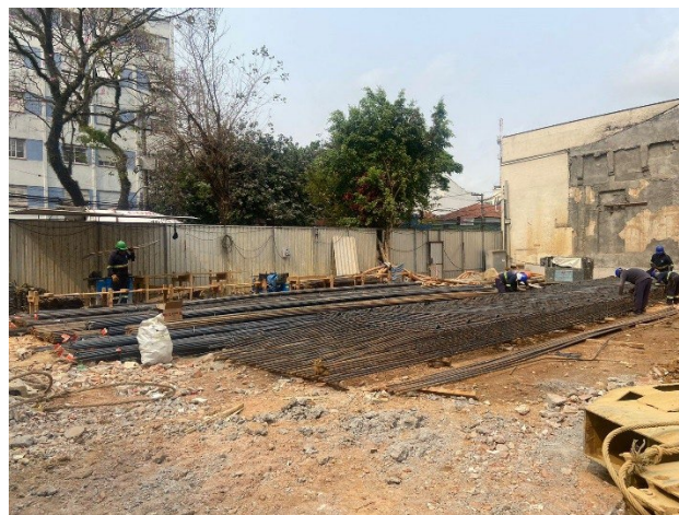
Armação das contenções do subsolo em parede diafragma em julho/24.
