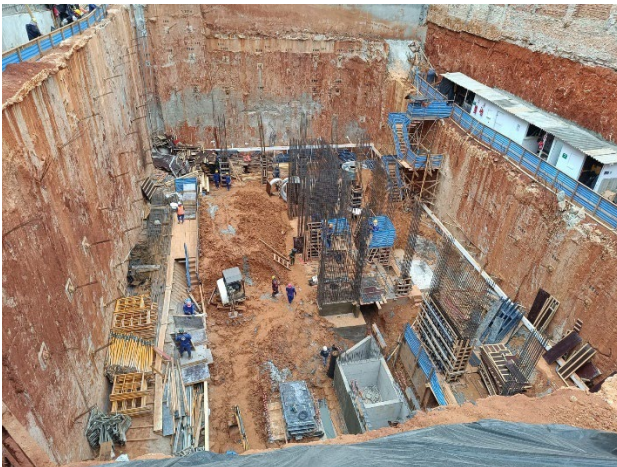
Armação pilares do 5º Subsolo.
