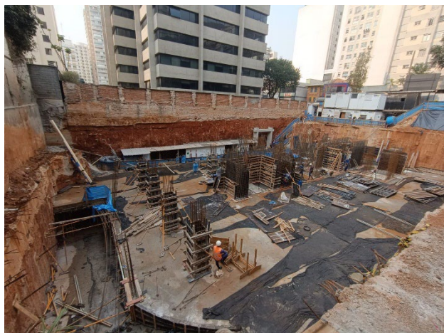
Laje do 2º Subsolo concretada.
