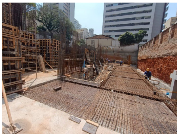
Laje do 1º Subsolo.
