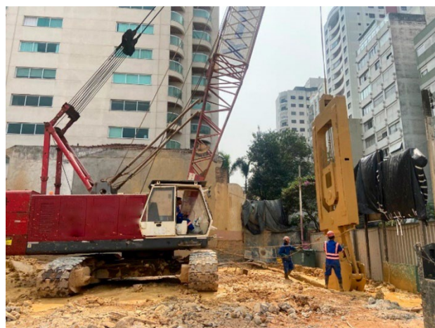
Execução de parede diafragma em setembro/24.
