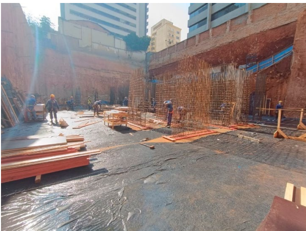
Laje do 4º Subsolo concretada.
