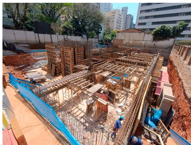
Armação e forma dosilares do Térreo.
