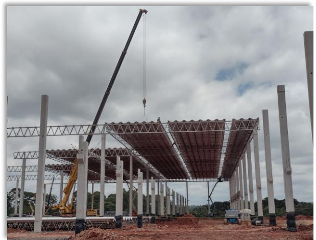
Montagem estruturas metálicas
