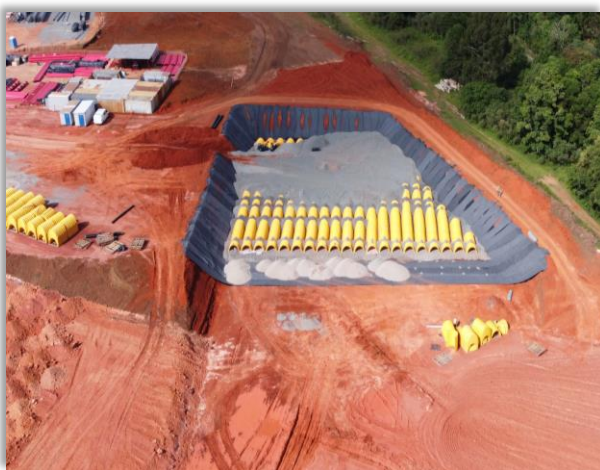
Vista Aérea Tanque de Retardo
