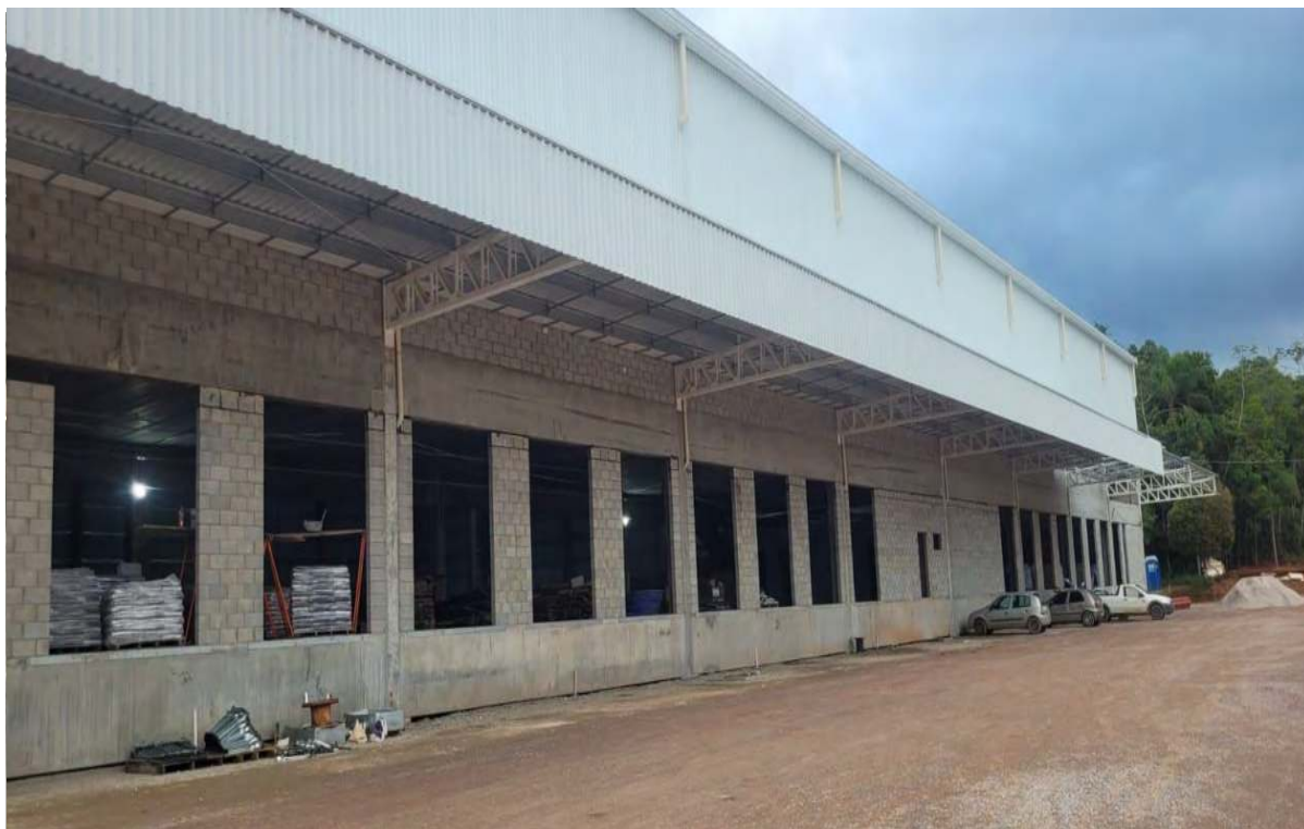
Execução de alvenaria de fechamento do galpão 2.
