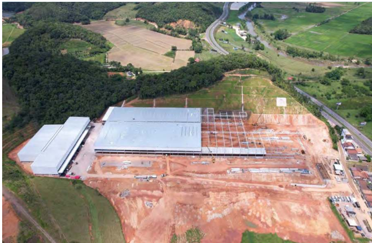
Locamento dos pilares, vigas e lajes pré-moldados do galpão 1.
