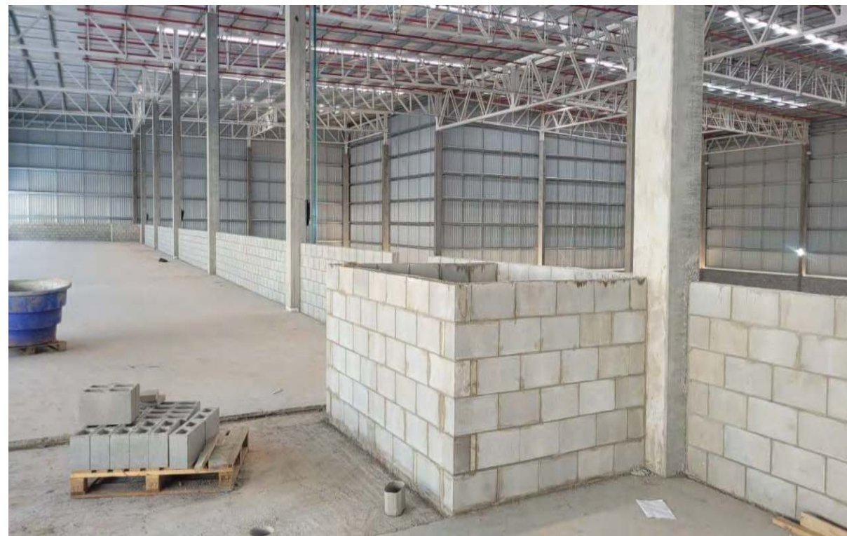
Execução de alvenaria de fechamento do galpão 2.
