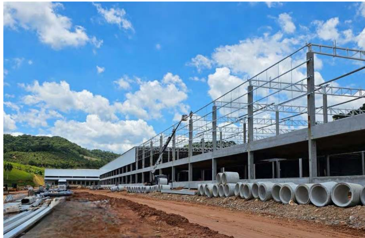
Locamento dos pilares, vigas e lajes pré-moldados do galpão 1.
