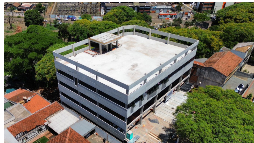
Foto da Obra
