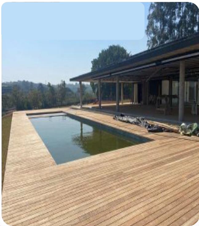
Avanço de obra Área externa (piscina)
