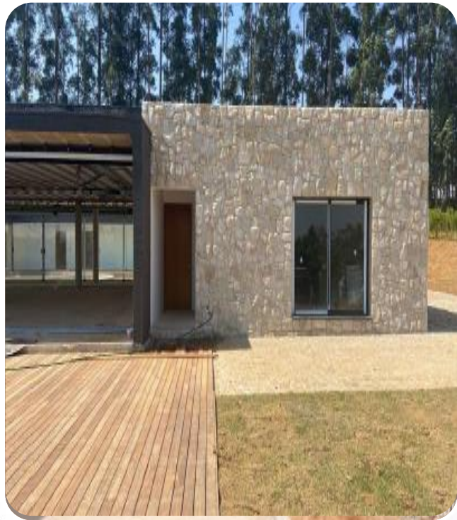
Avanço de obra Fachada principal
