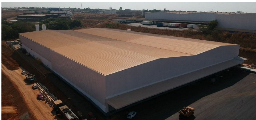
Vista Aérea do Galpão
