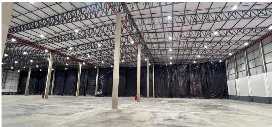
Área Interna do Galpão - Ampliação Fase 01
