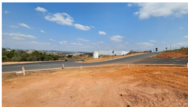
Foto da implantação da nova rotatória na avenida recém executada.
