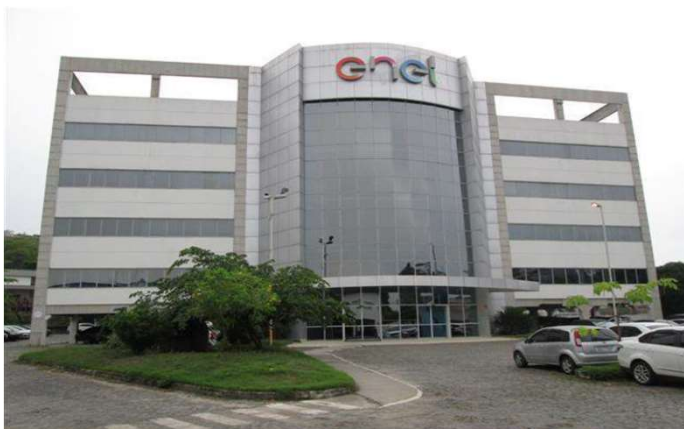
Ampla - São Gonçalo, RJ
