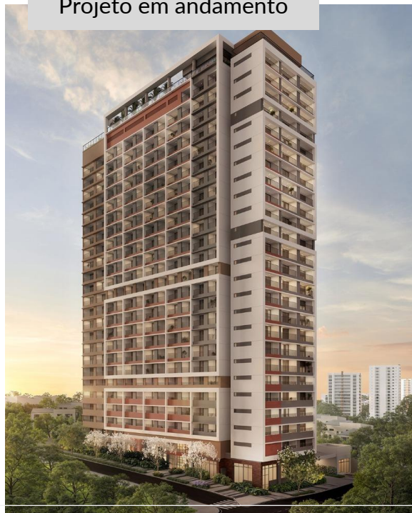
Projeto em andamento
