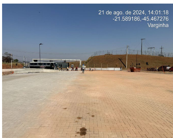
Foto obra de drenagem no Citlog Sul de Minas.
