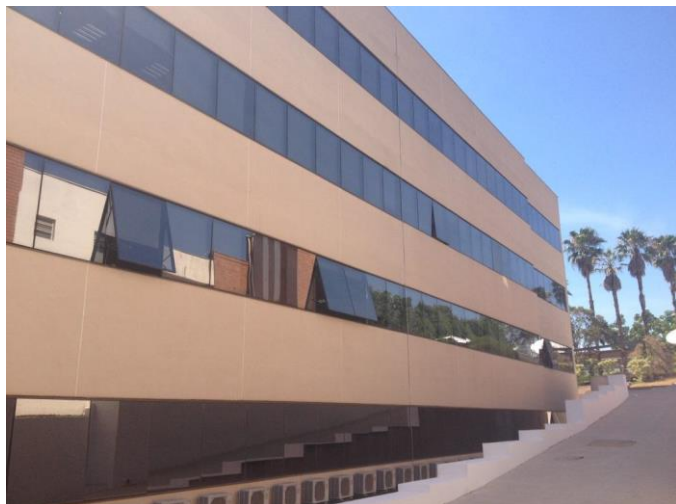
Bloco Administrativo 02 – fachada lateral
