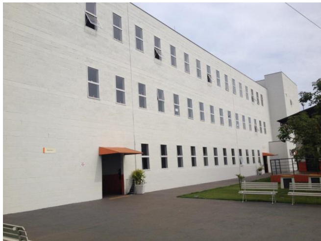
Bloco C – Fachada
