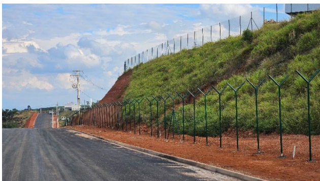
Fotos da via em obra.
