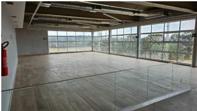
Foto obra restaurante Citlog Sul de Minas.
