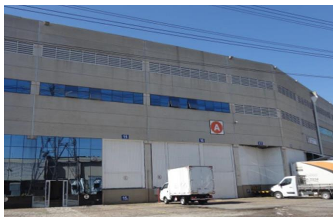
Foto do Galpão
