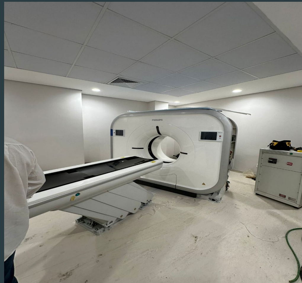
Execução da Montagem da Sala de Tomografia
