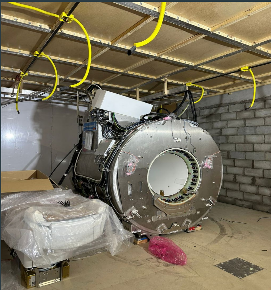
Execução da Montagem da Sala da Ressonância
