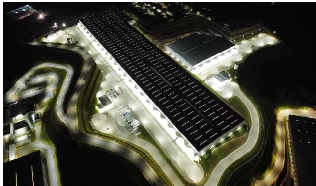
Execução de obras – Foto Panorâmica
