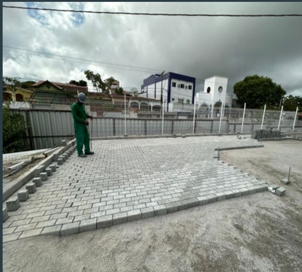
Execução do intertravado
