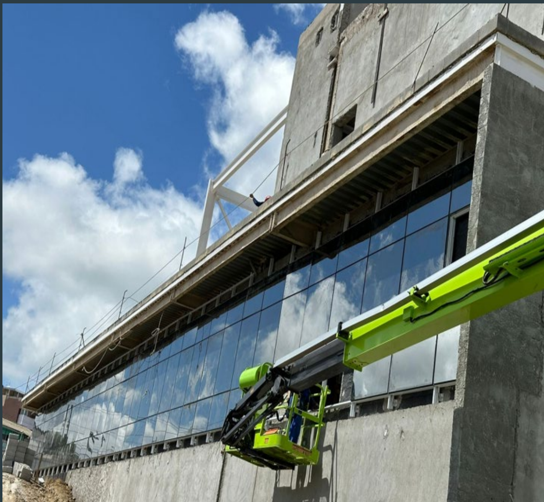
Fachada Externa/Lateral Pele de Vidro
