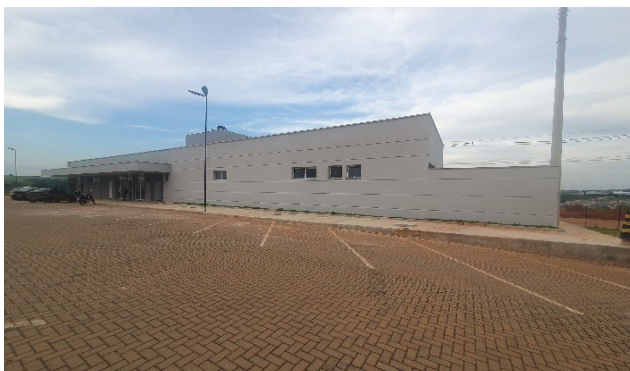
Foto obra restaurante Citlog Sul de Minas.
