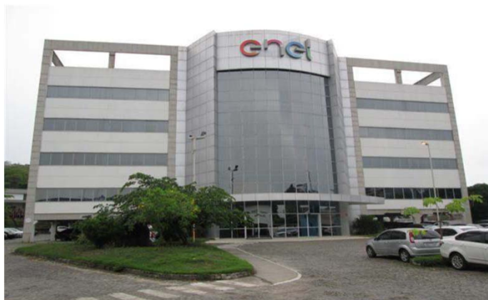
Ampla - São Gonçalo, RJ
