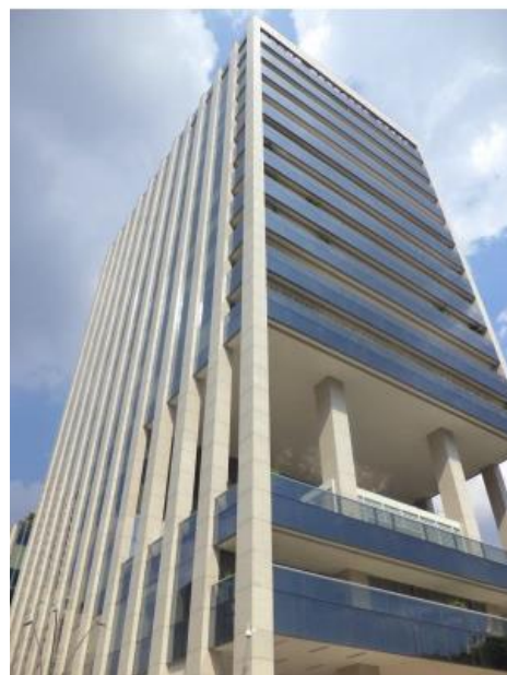
Fachada Traseira do Imóvel
